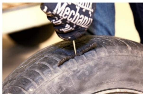
**3 Colmatez.** Retirez la lime et enfoncez la mèche, insérée dès le début dans le chas du poinçon, jusqu'à transpercer le pneu. Tournez la poignée du poinçon d'un quart de tour pour libérer la mèche, et retirez-le doucement.
